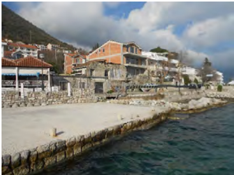
Slika: Izgrađena obala
