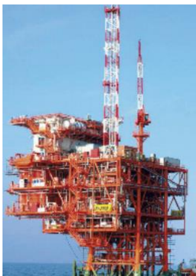
Slika 1.5 Čelična platforma rešetkaste konstrukcije oslonjena na morsko dno (izvor: http://www.ina.hr/UserDocslimages/Ina_casopis/zima09-10/44-45%20annamaria.pdf )
