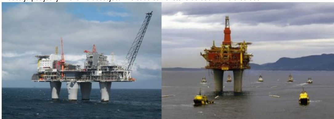
Slika 1.7 Betonske gravitacijske platforme (izvor: http://en.wikipedia.org/wiki/Offshore_concrete_structure#mediaviewer/File:Troll_A_Platform.jpg )
