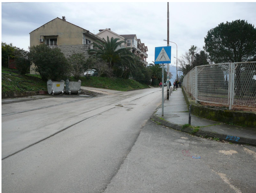
Slika 4. Lokalni put na koji će biti priključena lokacija projekta
