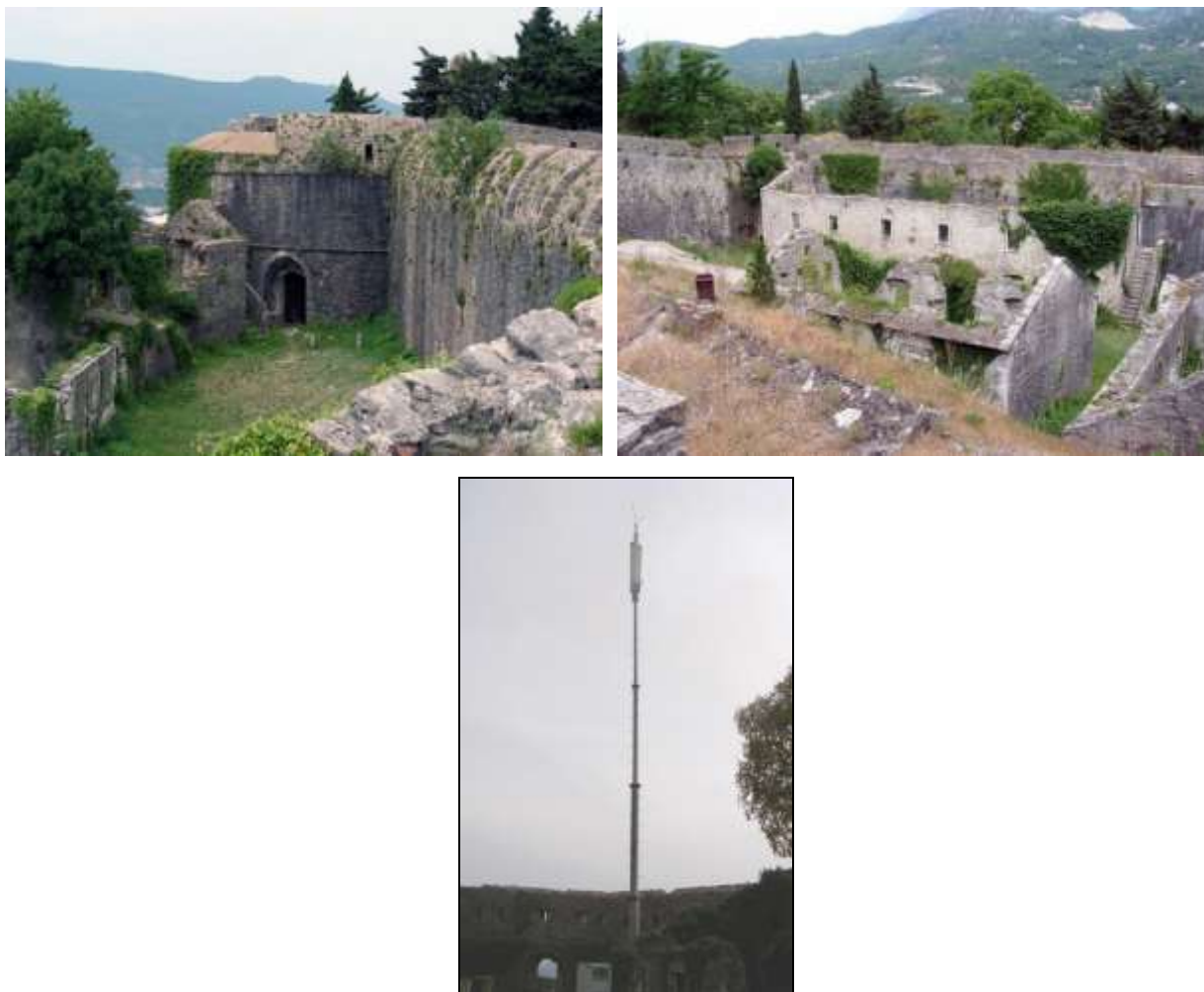
Slika 2.2. Izgled lokacije bazne stanice sa okruženjem
