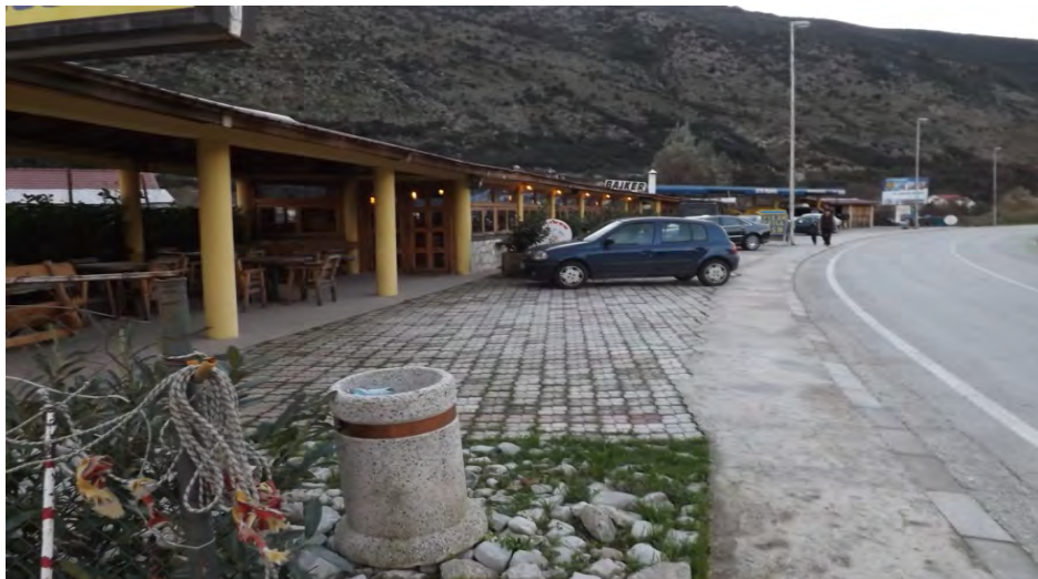
Slika 2.1. Lokacija 98/2 k.o. Sutorina, pogled sa istočne strane, od restorana “Bajker”
