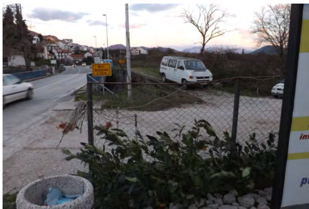
Slika 5.14. Položaj mosta – pogled s lokacije
