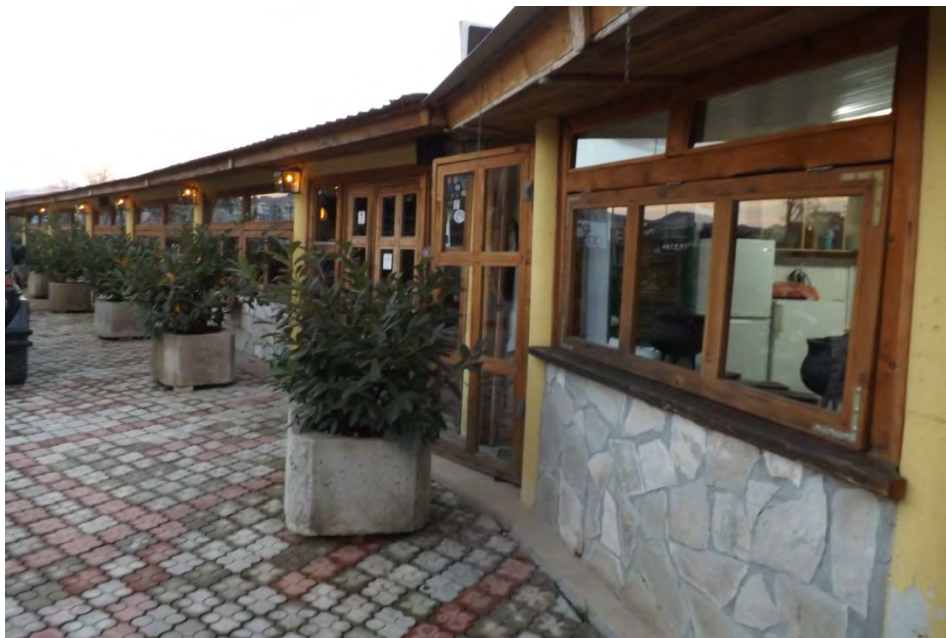
Slika 3.3. Glavni objekat zahvata 98/2, "Bajker" – restoran građen u kombinaciji drvo - kamen
