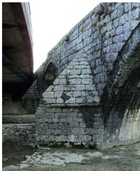
Slika 5.16. Kljun il svodovi mosta
