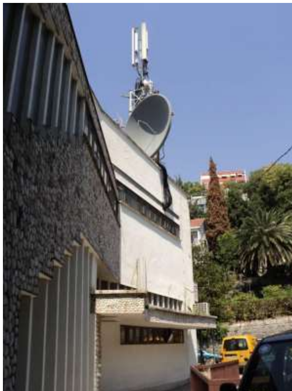
Slika 2.1. Izgled lokacije i neposrednog okruženja lokacije
