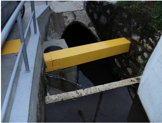
Sl. 7. Ulazni portal, uspor vode
