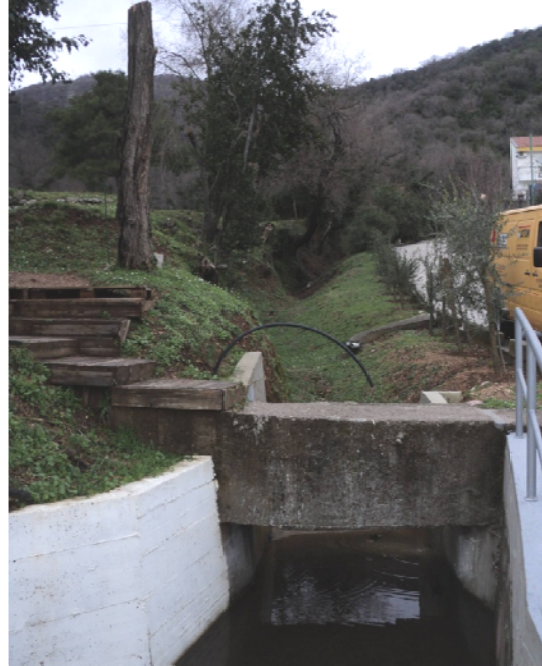
Sl. 2. Korito istočnog bujičnog potoka (cijev reg. vodovoda je u betonskom mostu )
