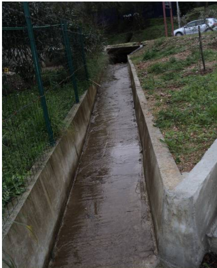
Sl. 9. Izbetonirano korito „B“ ispod lokacije magistrale
