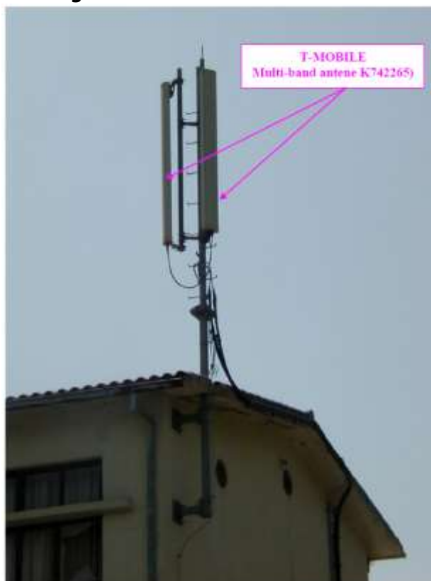
Raspored opreme na stubu
