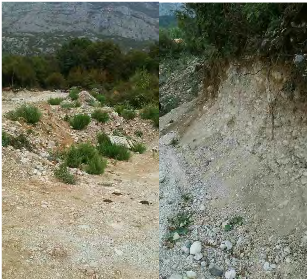
sl. 2.4 lokacija sa koje se eksploatiše kameni agregat
