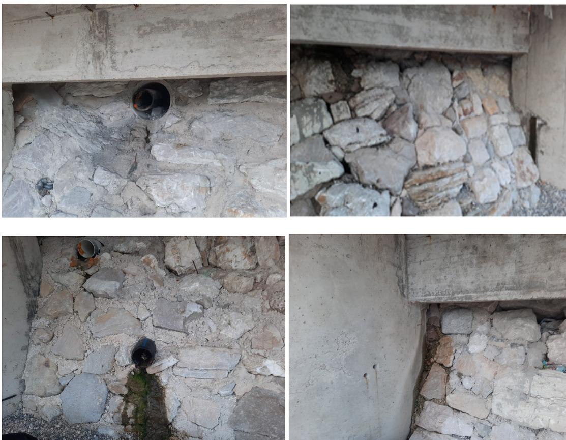
2.a.1- 2.a.4.Na predmetnoj lokaciji nalaze se ispusti otpadnih voda, koje nijesu priključene na fekalnu kanalizaciju, već se direktno ispuštaju u more.
