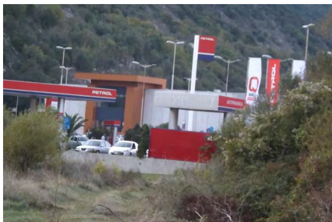
Slika 5.1.1. Benzinska stanica udaljena 150 m
