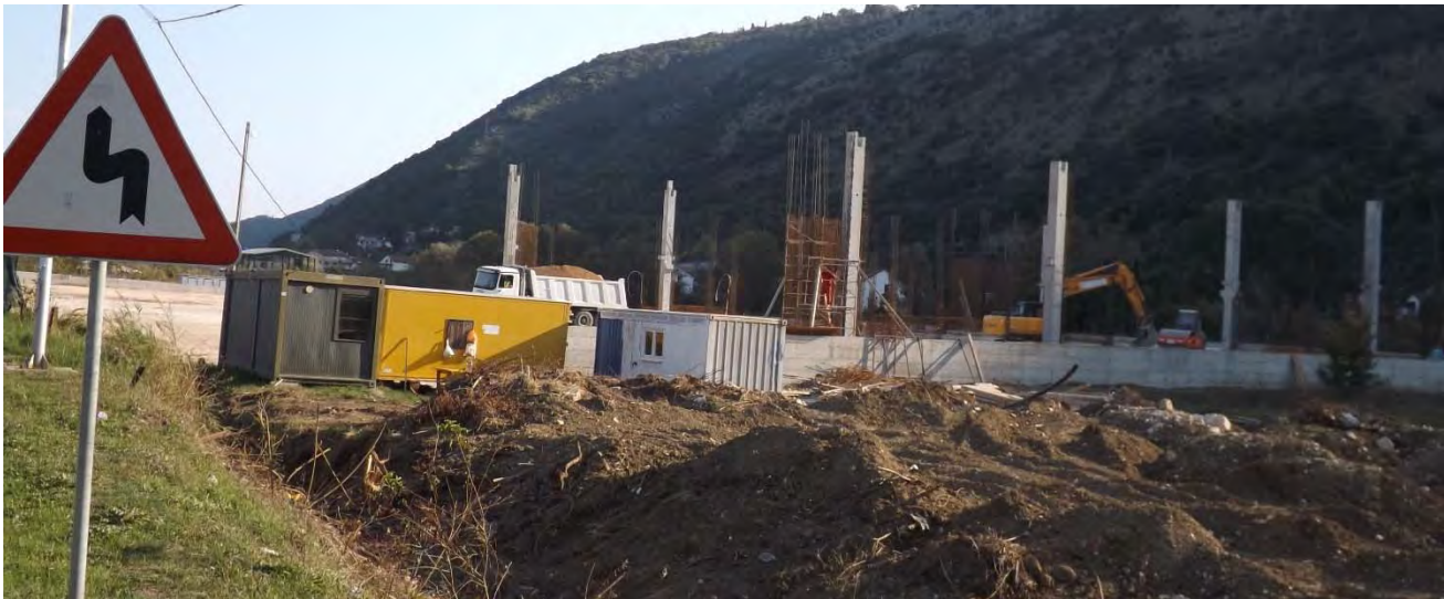
Slika 3.3.1. Gradilište na lokaciji 6501. sa postavljenim kontejnerima za radnike i upravljanje gradilištem
