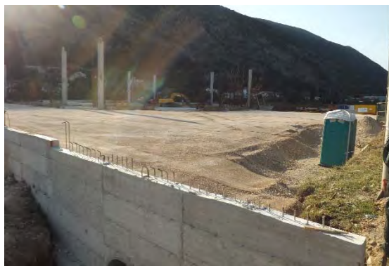
Slika 6.1.2. Izgled iskrčenog terena pripremljenog za građenje
