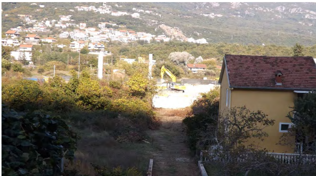
Slika 5.1.5. Pogled na lokaciju na Njivičkog puta, u vrijeme ravnjanja terena.
