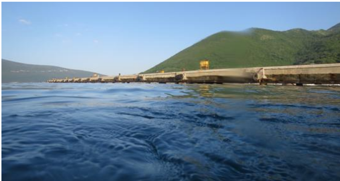
Slika 2.1.4. Postojeći betonski dok na šipovima
