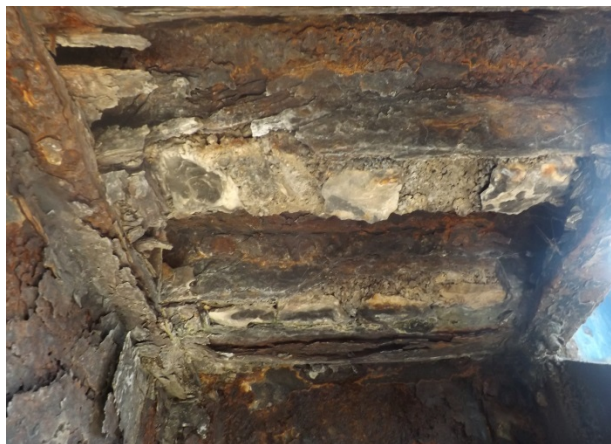
Slika 6.28. Korodirana čelična konstrukcija
