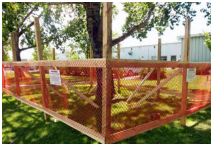
Slika 8.3. Zaštita stabala od mogućeg oštećenja tokom građenja
