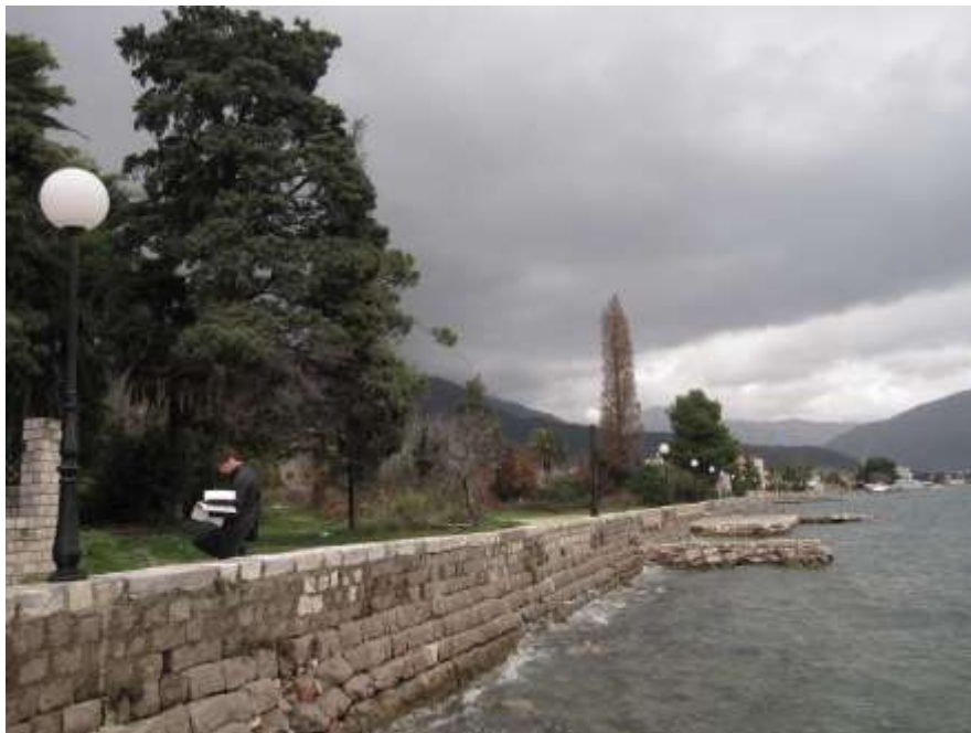
b) Fotografija lokacije - pogled sa mora
