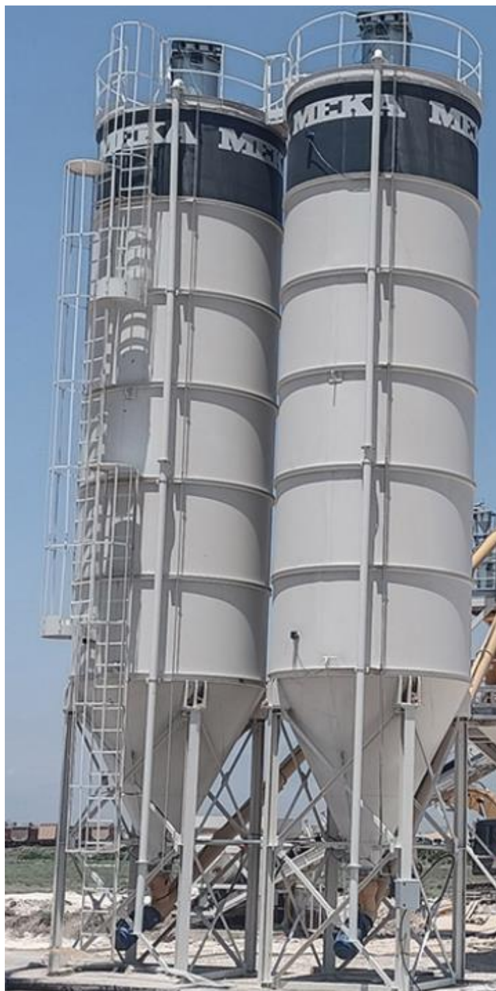
Slika 13. Silosi za skladištenje cementa
