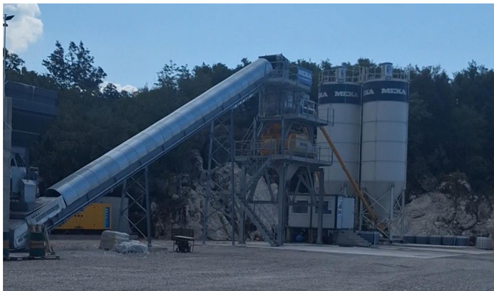
Slika 11. Postrojenje za proizvodnju betona
