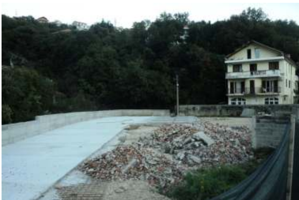
Slika 5.1. Zahvat iz Glavnog projekta autoperionice, sa započetim pripremnim radovima na uređenju parcele
