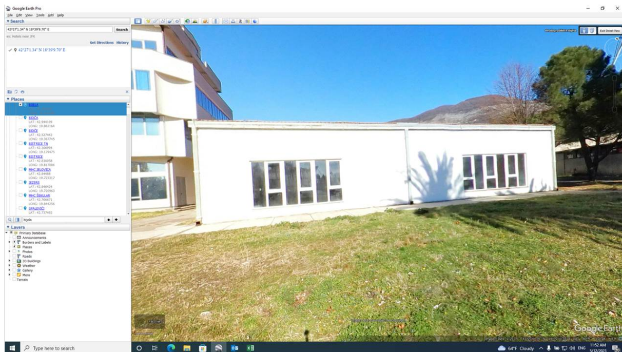
Slika 7.5. Objekat koji dijelom ulazi u horizontalnu zonu nedozvoljenog zračenja
