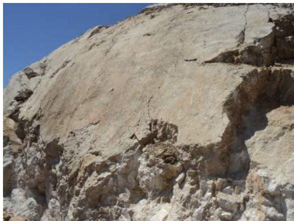
Slika 4.5. Geološki sklop na lokaciji
