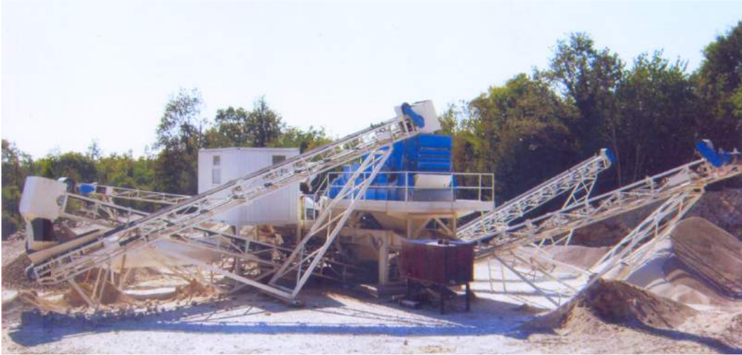
Slika 3.4. Drobilično postrojenje „Bajoni“
